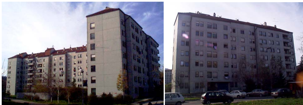
Slika 5.7 Reprezentativna zgrada na Novom Beogradu na kojoj su vršena merenja
